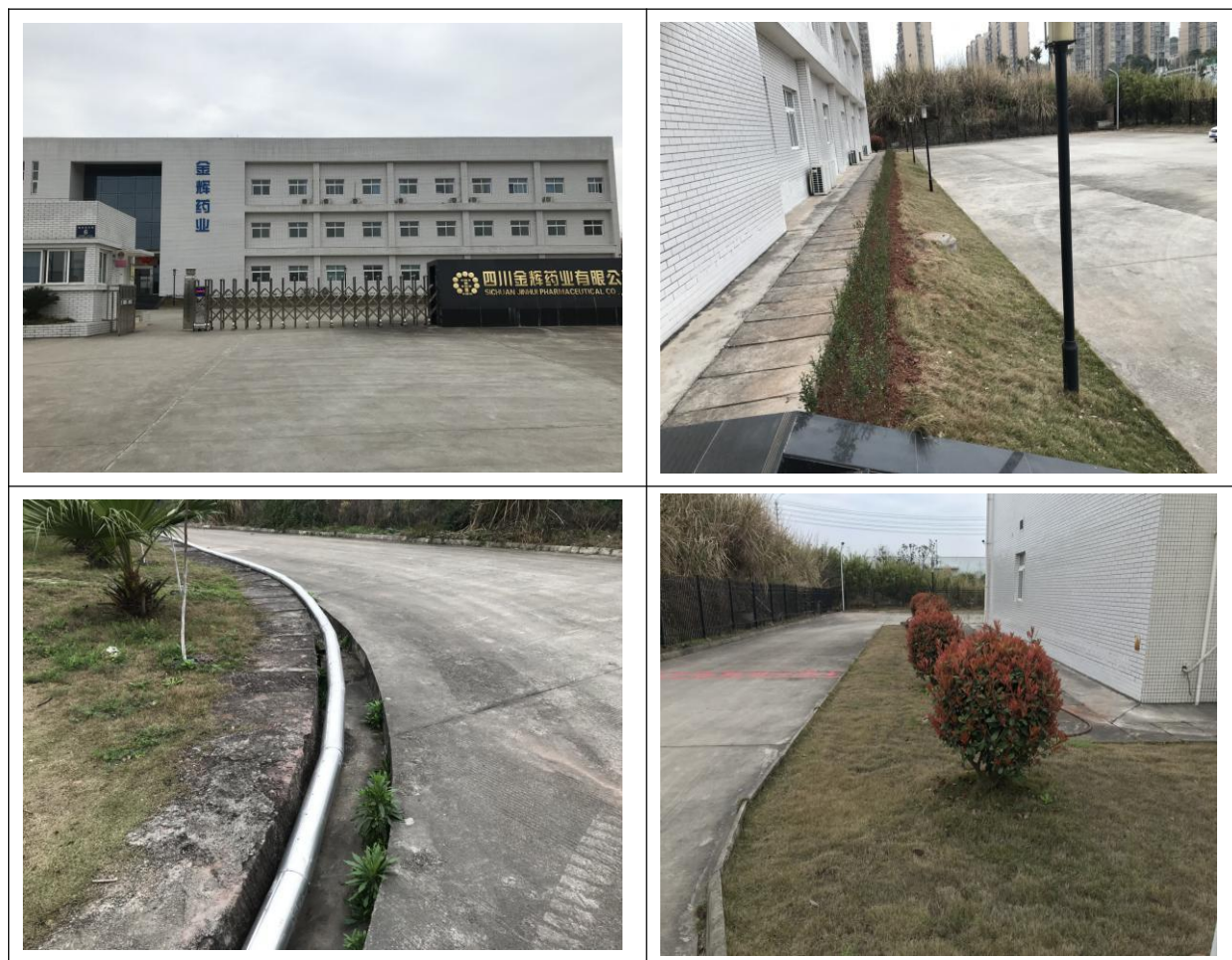
图 5-1 现场水土保持运行情况
